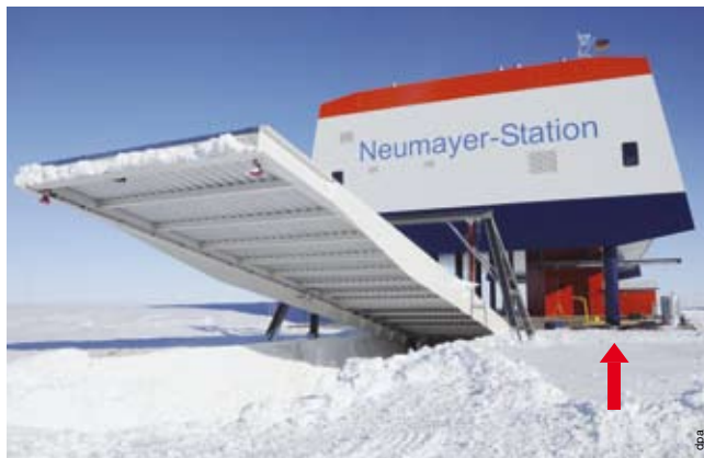
Für die deutschen Klimaforscher im ewigen Eis sind bei Temperaturen um -50°C Sicherheit und Zuverlässigkeit ihrer Station überlebenswichtig: An Bord der hochmodernen Polarstation Neumayer III sorgt HYDAC mit gespeicherter Power und zuverlässig reinen Betriebsmedien für die langfristige Zuverlässigkeit der hydraulischen Anlage und der 16 höhenverstellbaren Stelen.
