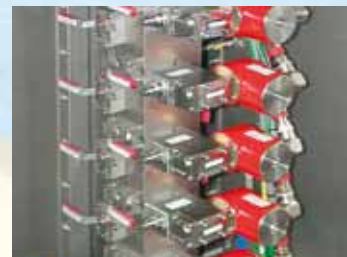
Robinet à boisseau sphérique dans le panneau de distribution topside, DN 25 - 50.
