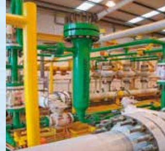
Filtre mono-éthylglycolique (MEG) , 100 µm et 200 µm travaillant à 300 bar, pour la déshydratation du gaz sur les plates-formes Offshore.
