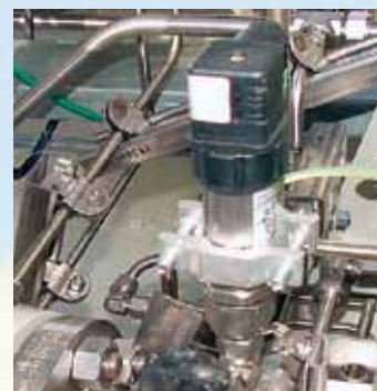
Transmetteur de pression pour la surveillance des différents niveaux de pression dans les compresseurs.
