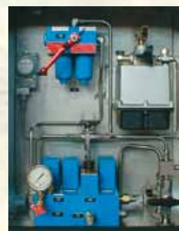
Filtre en ligne commutable pour une Unité de verrouillage de vanne.
