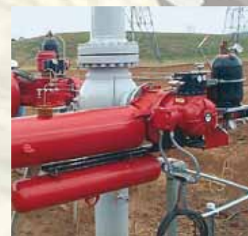
Accumulateurs à vessie avec revêtement spécial pour actionner la vanne.
