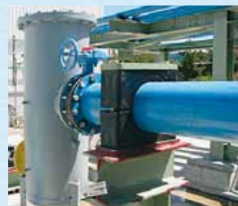
Fixation de tuyau sur barge de forage avec collier de serrage selon DIN 3015 avec revêtement offshore spécial.
