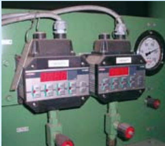
Druckschalter EDS 1700 zur Wandmontage.
