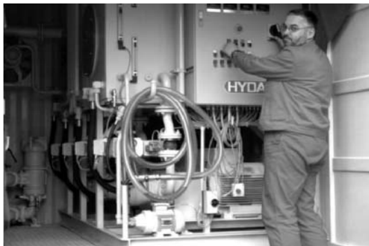
HYDAC Techniker bauen den FluidCube für den Einsatz bei Inbetriebnahmespülungen großer Nennweiten.
