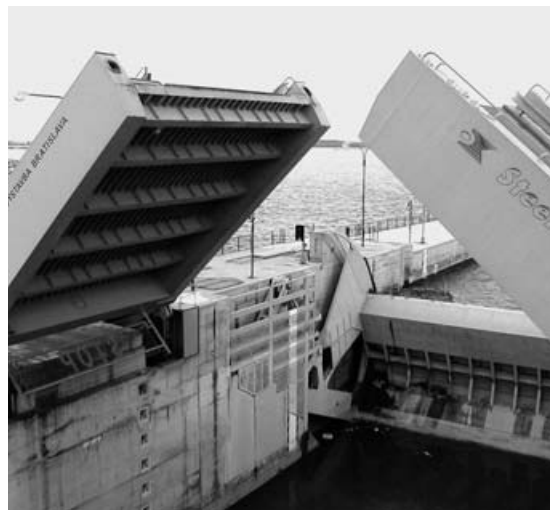
Hydraulik, die klappt: HYDAC Technologie in einer Klappbrücke. Darunter: HYDAC Technologie im Stauwerk einer Schleuse. Und am Horizont: HYDAC Technologie in einem großen Gasleitungsprojekt der Slowakei.
